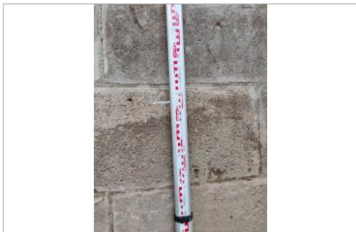
Trace sur la culée RD
