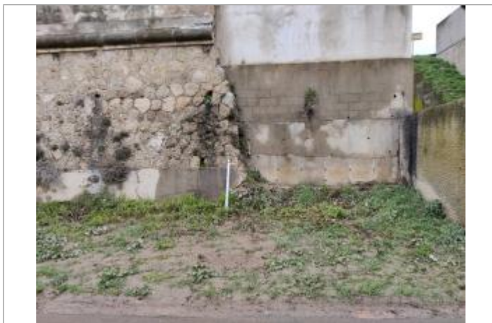
Mur de soutènement
