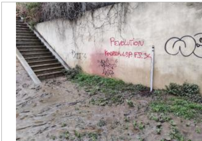
Mur de soutènement
