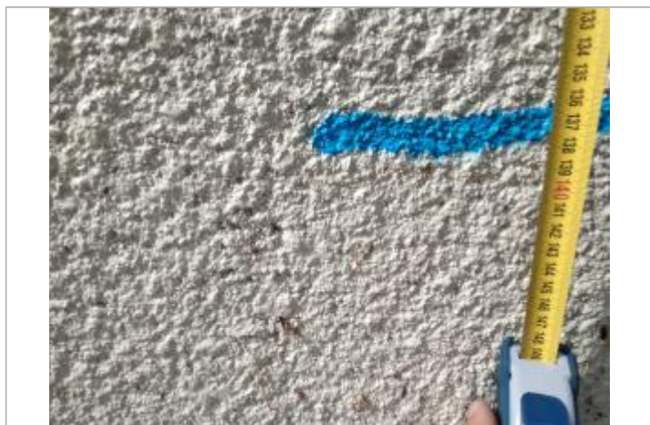
Trace sur le mur
