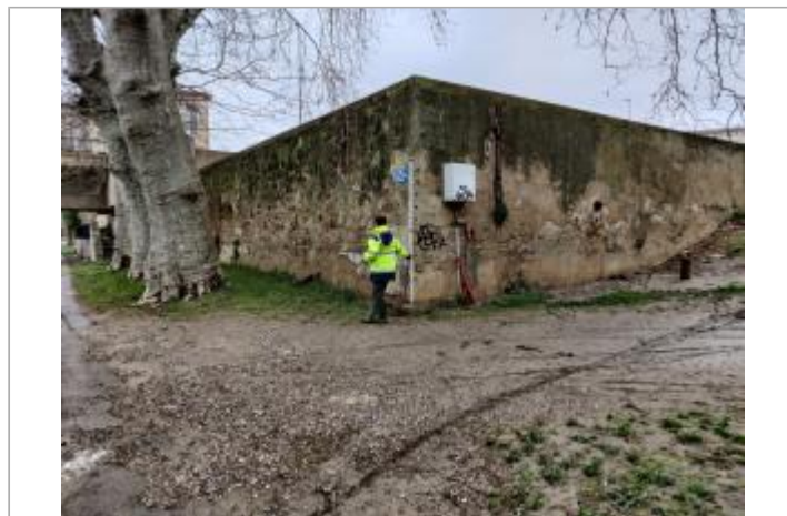
Mur de soutènement
