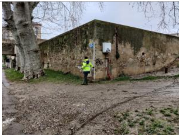
Mur de soutènement
