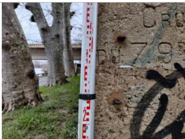
Trace sur le mur
