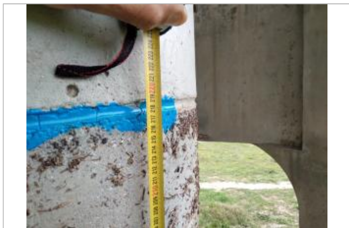
Trace sur l'axe de l'escalier
