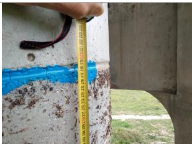
Trace sur l'axe de l'escalier
