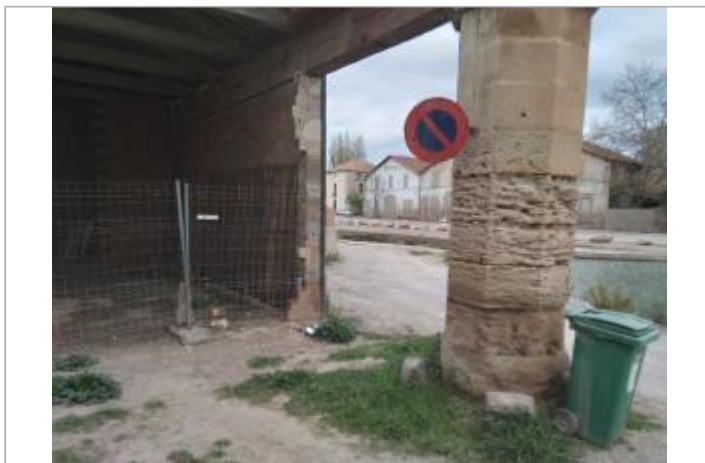
Mur du préau
