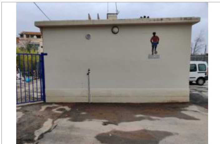
Mur des vestiaires
