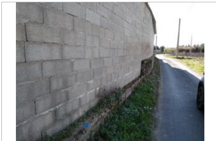
Mur du bâtiment
