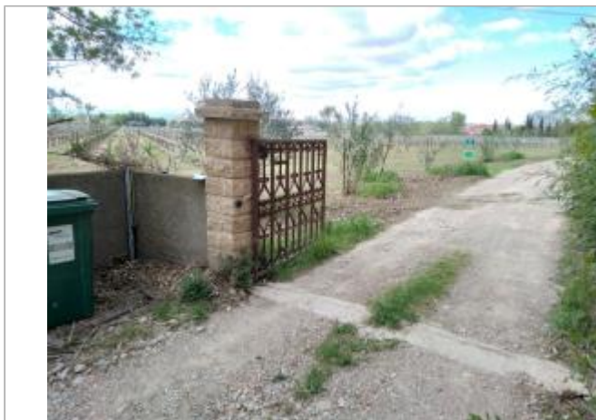
Muret espace poubelles
