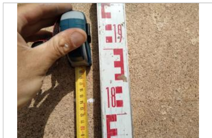
Trace sur le mur
