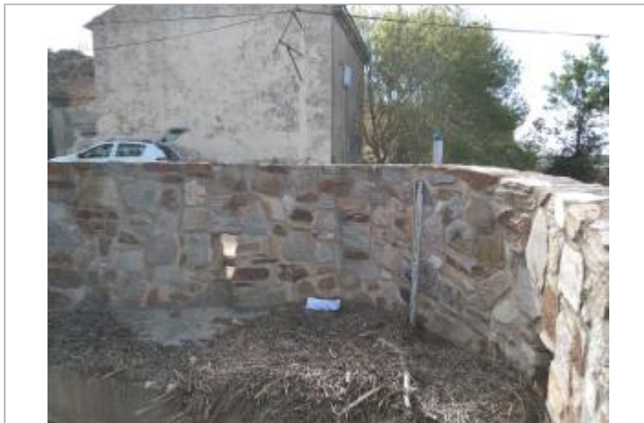
Parapet du pont
