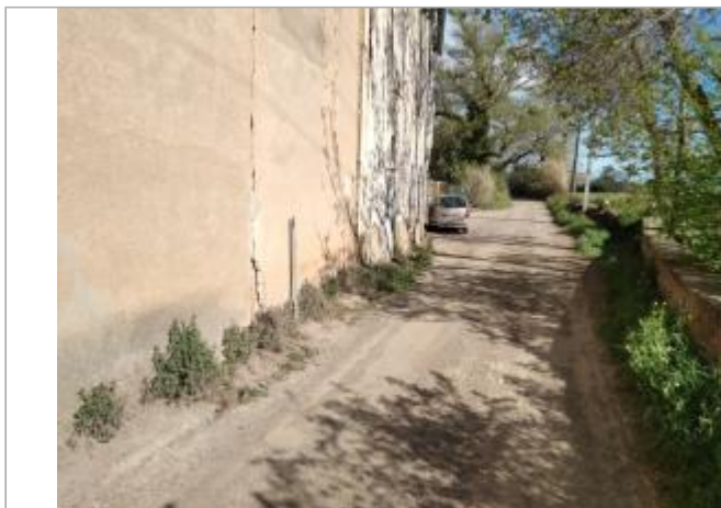
Mur du bâtiment
