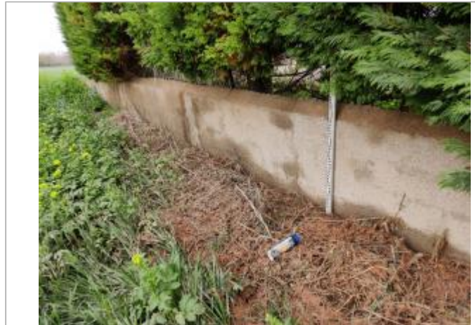
Mur du terrain de tennis
