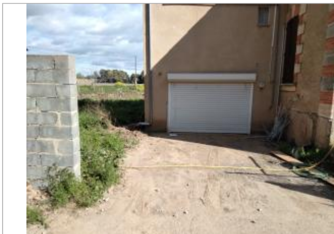
Mur du garage
