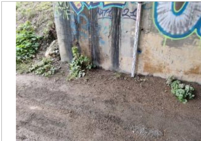
Culée de pont
