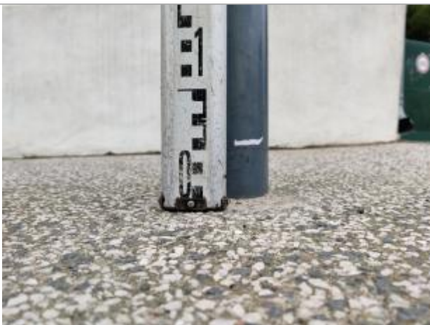
Trace sur le poteau
