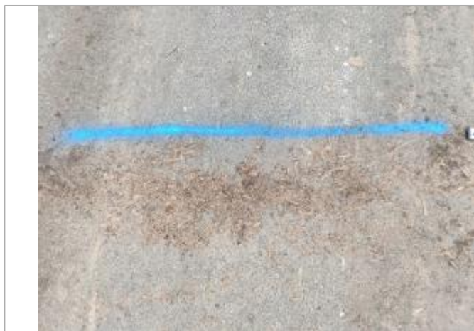
Dépôt sur la chaussée
