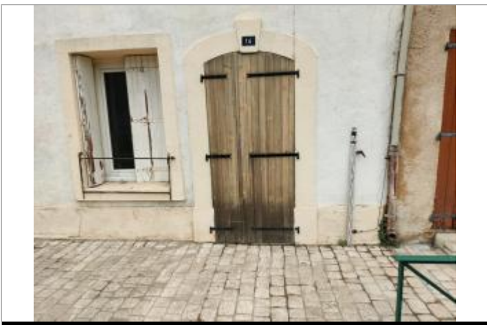
Mur de la maison
