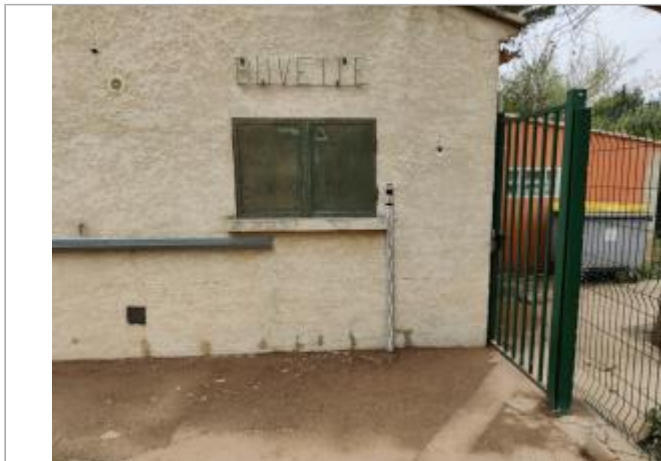
Mur du bâtiment
