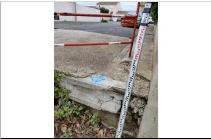
Poutre béton de soutènement
