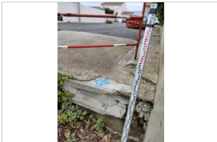
Poutre béton de soutènement
