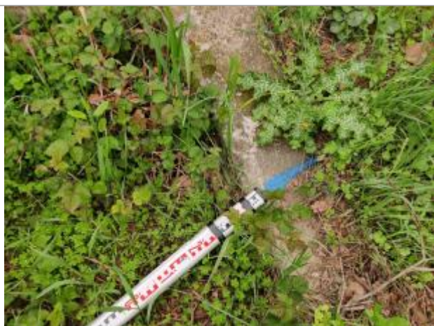
Trace sur l'ouvrage
