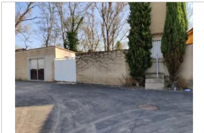
Escaliers ancienne entrée
