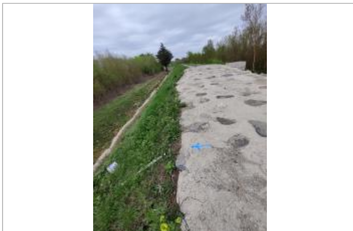
Talus de digue
