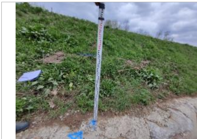
Talus de digue
