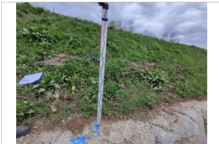
Talus de digue
