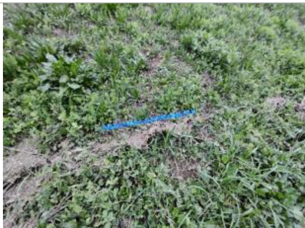
Dépôt contre la digue
