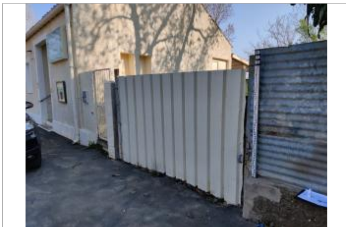
Palissade en tôle ondulée
