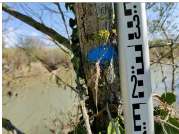
Débris végétaux sur l'arbre
