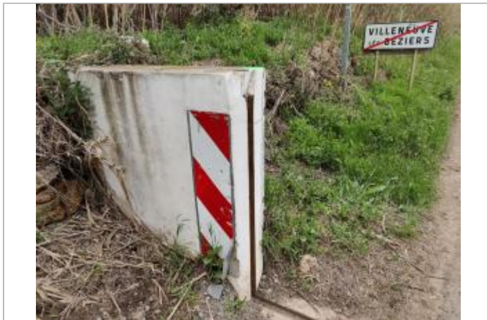
Culée de batardeau
