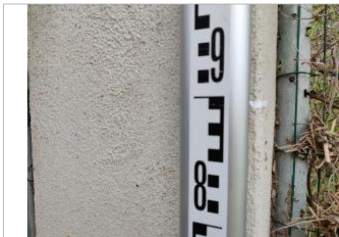
Trace sur le montant
