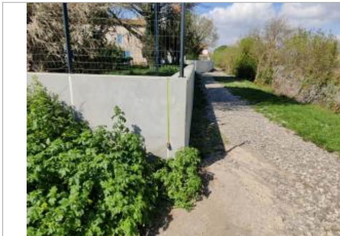
Angle du mur de soutènement
