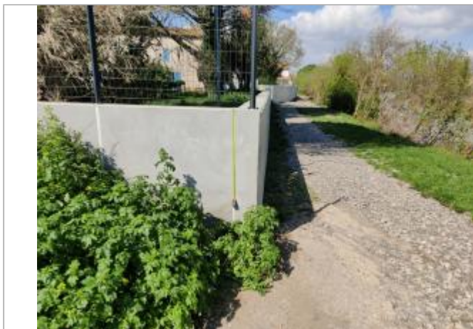
Angle du mur de soutènement
