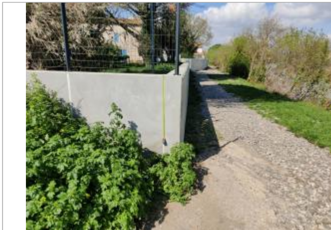
Angle du mur de soutènement
