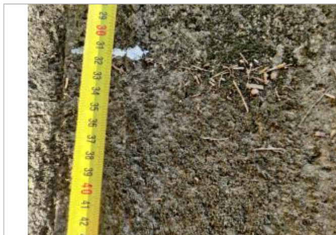
Trace à l'intérieur du siphon
