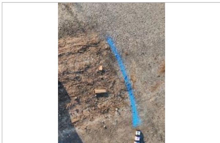
Dépôt sur la chaussée
