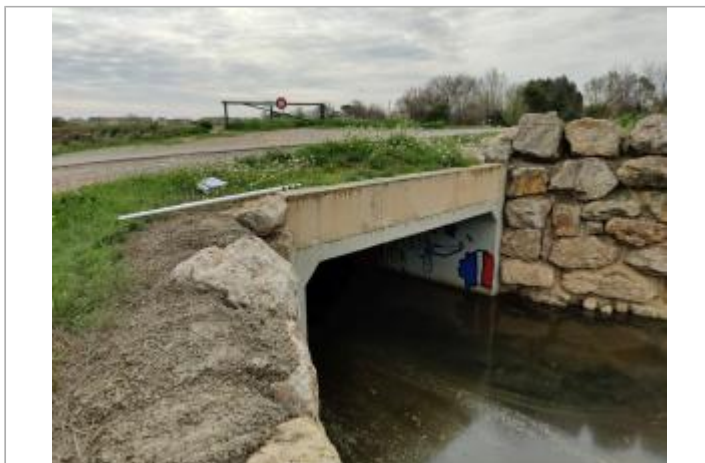
Mur du dalot
