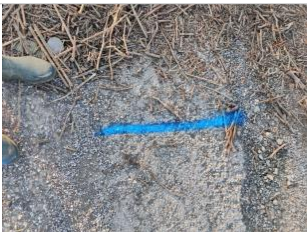
Dépôt sur la chaussée
