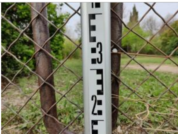
Débris végétaux dans le portail
