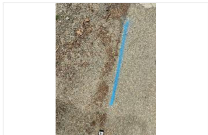
Dépôt sur la chaussée
