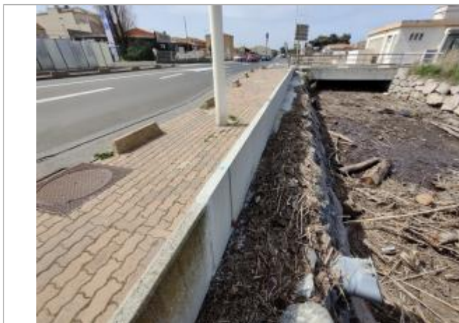
Mur digue du canal
