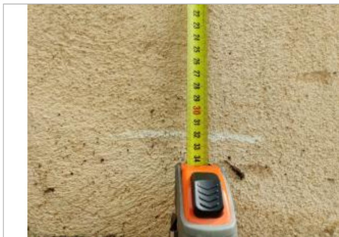
Trace sur le massif Béton
