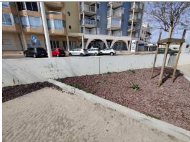
Mur d'enceinte du parking
