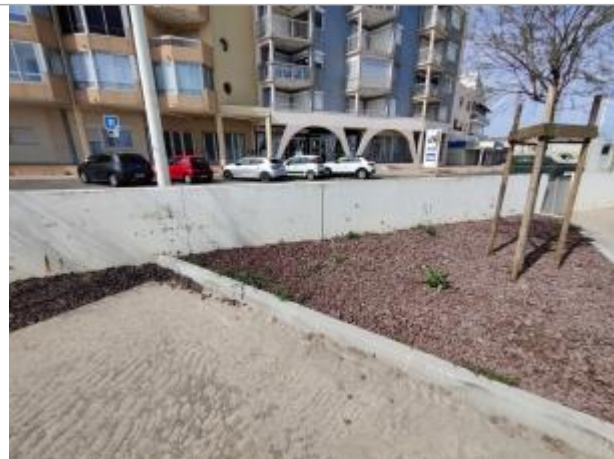
Mur d'enceinte du parking
