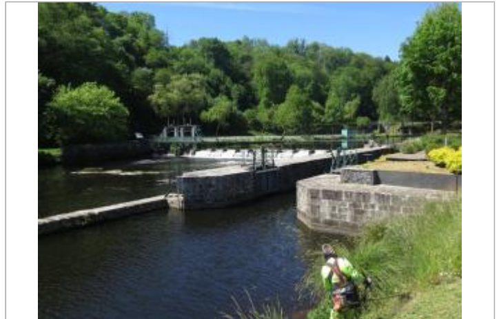
aval de l'écluse de Saint-Nicolas-des-eaux
