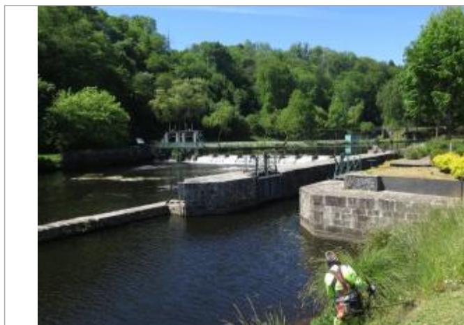
aval de l'écluse de Saint-Nicolas-des-eaux
