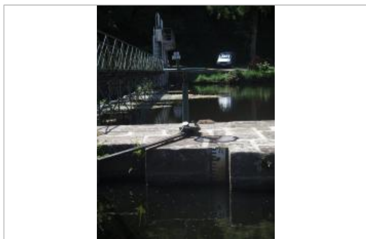
Echelle amont de l'écluse de Saint-Nicolas-des-eaux
