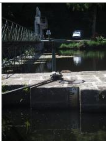
Amont de l'écluse de Saint-Nicolas-des-eaux
