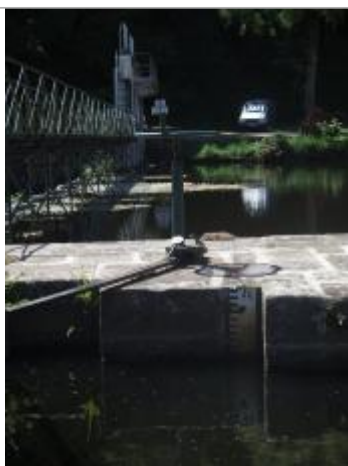
Amont de l'écluse de Saint-Nicolas-des-eaux
