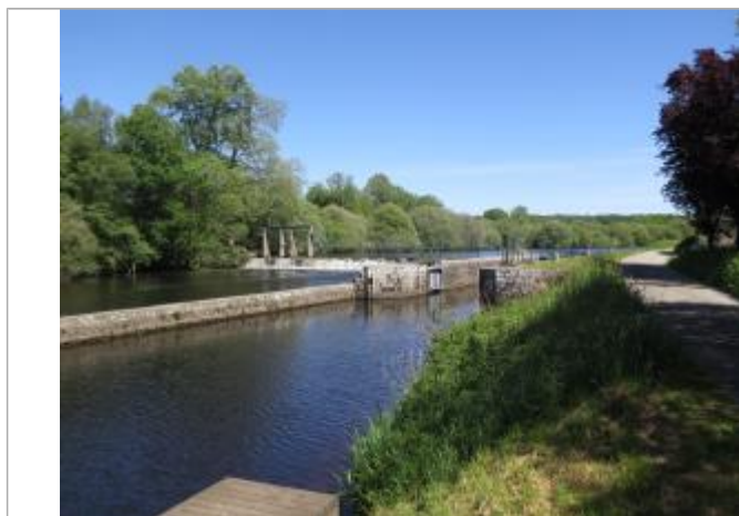
Site de l'échelle aval disparue de l'écluse du Guern
