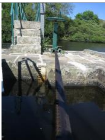
Echelle amont de l'écluse du Guern
