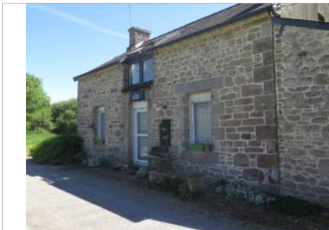
maison éclusière du Guern à Pluméliau-Bieuzy
