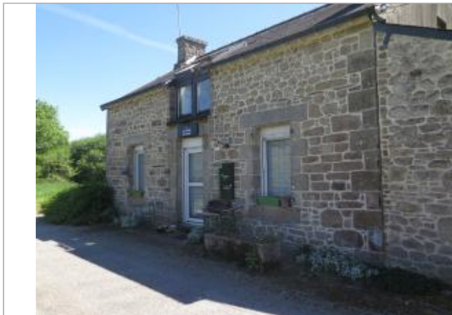
maison éclusière du Guern à Pluméliau-Bieuzy
