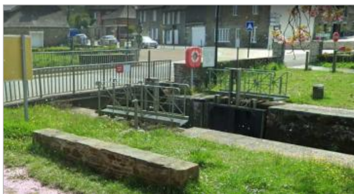
Aval de l'écluse de Gouarec sur le canal de Nantes à Brest
