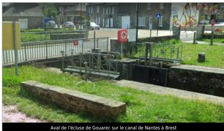
Aval de l'écluse de Gouarec sur le canal de Nantes à Brest
