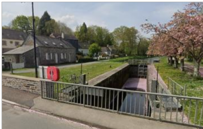
Echelle aval (disparue) de l'écluse de Gouarec sous la RD201
