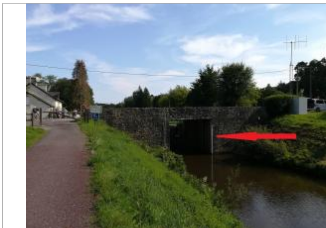
Ecluse de Cadoret à Pleugriffet - station Vigicrues
