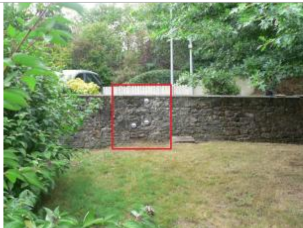
Muret, rue du 4 juin 1944
