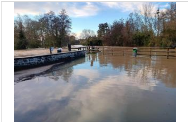
Deversoir sur le Meu le 27/01/2025 - photo CEREMA Ouest
