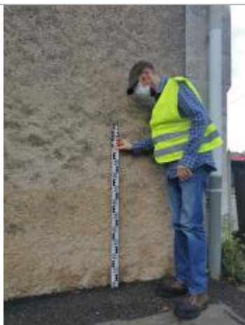
prise de cote mur sud-ouest du 5 rue du hameau à Clémery
