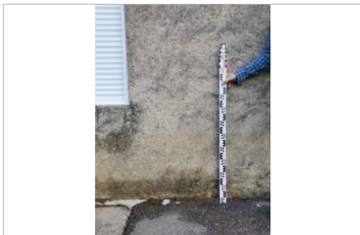
prise de cote mur sud du 5 rue du hameau à Clémery
