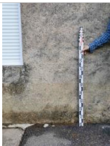
prise de cote mur sud du 5 rue du hameau à Clémery
